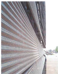
Fassadenschnitt mit Sonnenschutzlamellen
