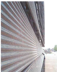
Fassadenschnitt mit Sonnenschutzlamellen
